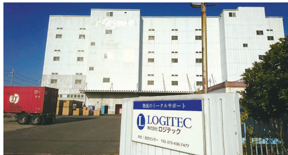
ロジテック本社
